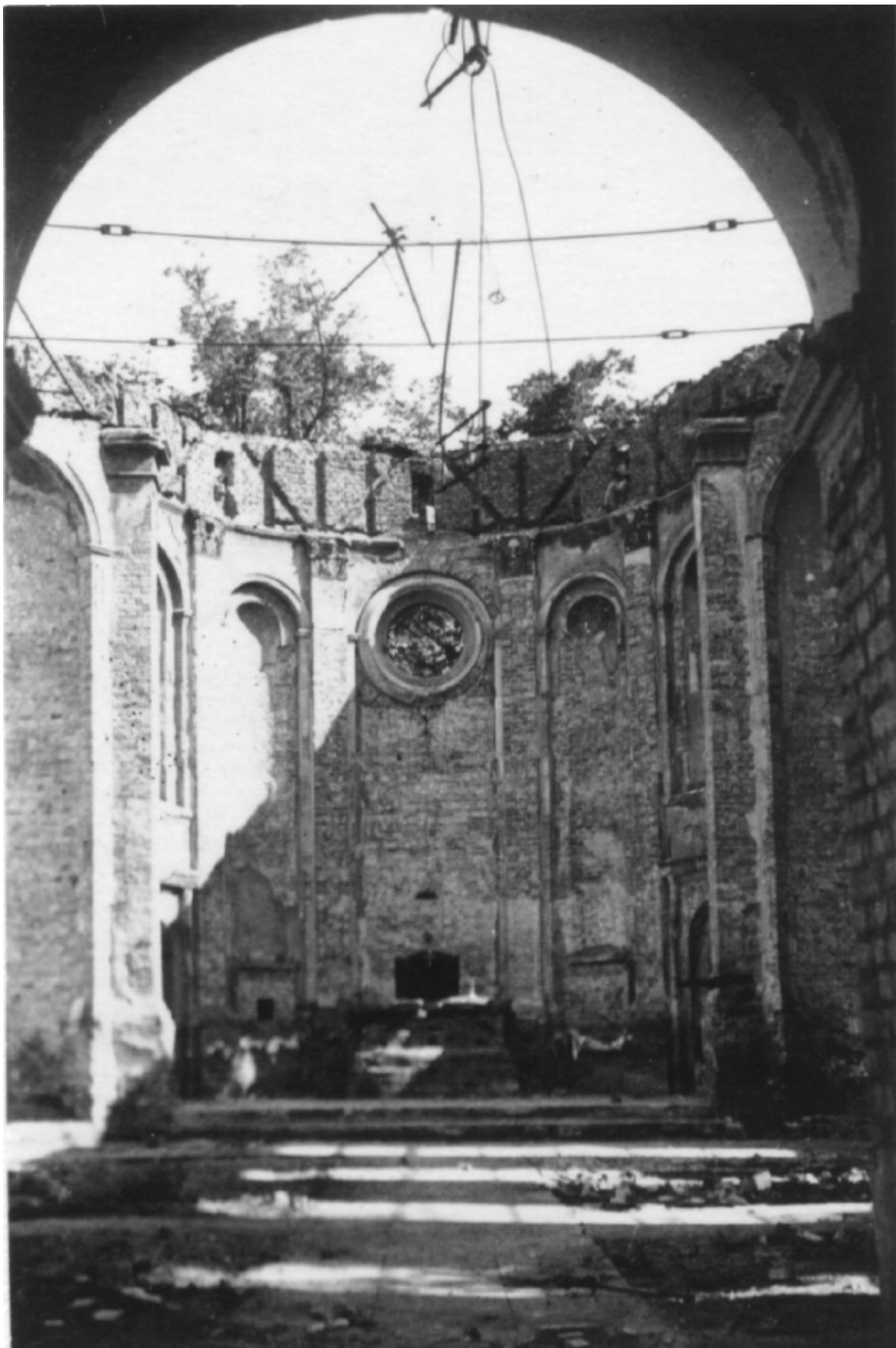
Abbildung 4: Inneres der am 26. April 1945 zerstörten Dreifaltigkeitskirche
