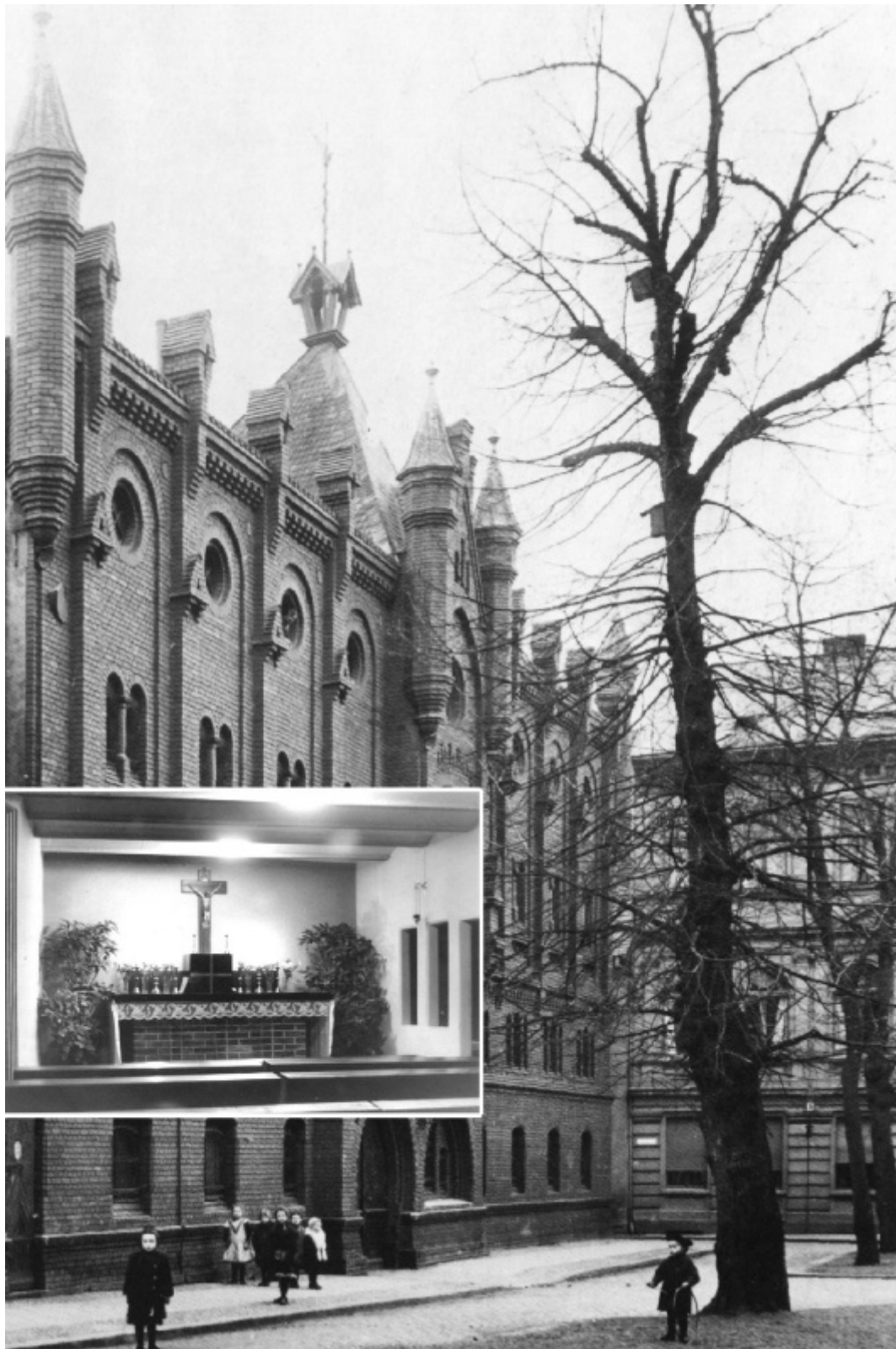
Abbildung 6: Notkapelle im Speichergebäude am Katharinenkirchplatz von 1946 - 1949
